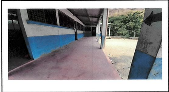
Foto1: Colocación de piso cerámico.
