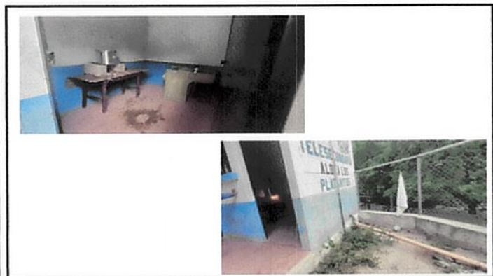
Foto 3: Colocación de pila y sistema de drenaje y agua potable en cocina
