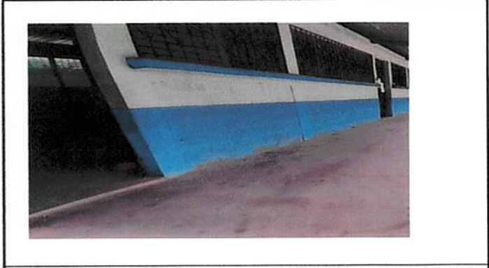
Foto 2: Pintura en interior y exterior centro educativo.
